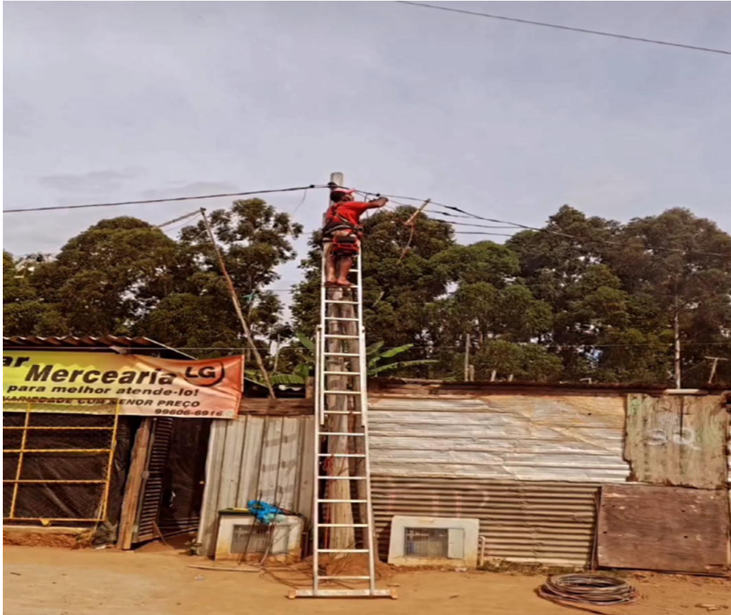
Figura 2: Troca da fiação no Assentamento Miguel Lobato, em 23 de junho de 2023.
